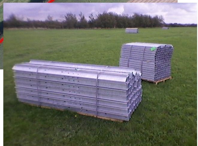
Materialen tbv bouw "tafels" voor solarpark
